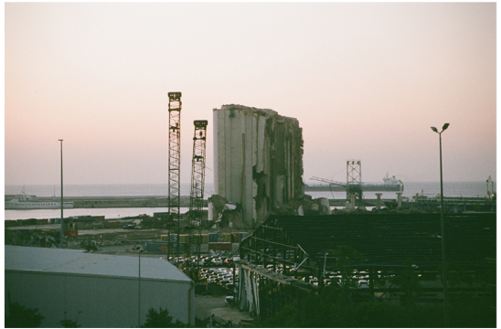
Silos de Beirute pós explosão
